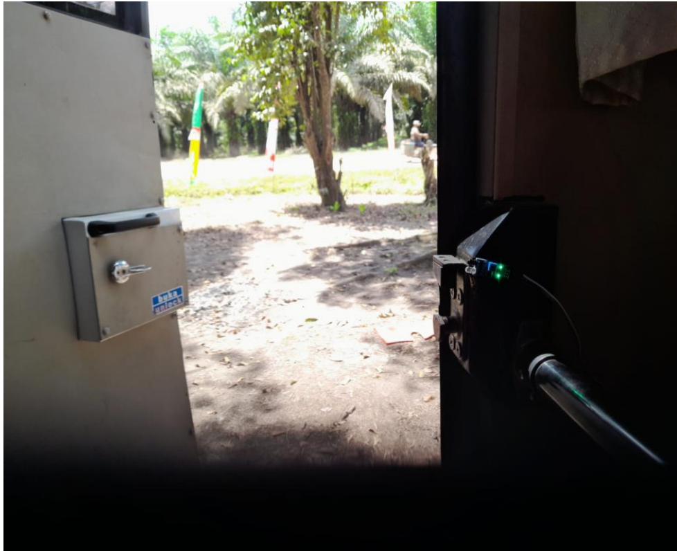
Gambar 3. 9 Pemasangan sensor di pintu keluar
